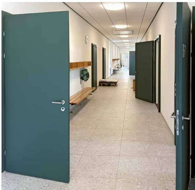
Gang des sanierten Teils
