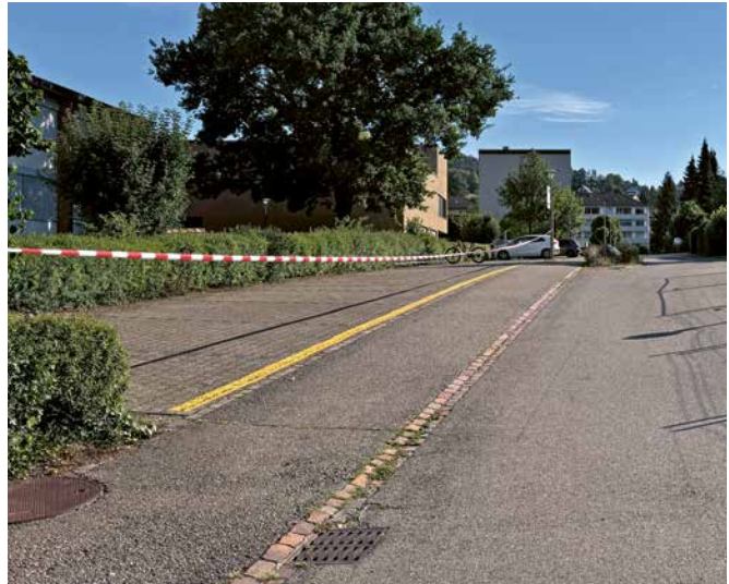
Mit der Aufhebung dieses Strassenabschnitts entfallen auch acht Parkplätze.
