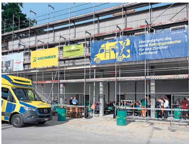
Im Rohbau der zukünftigen Rettungswache des Spitals Bülach fand gestern die traditionelle Aufrichte statt.
