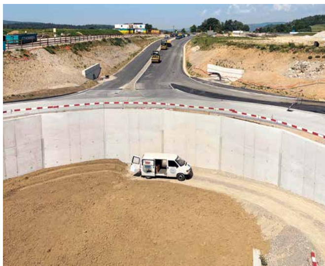
Die neue Ein- und Ausfahrt des Kreisels Chrüzstrasse in Richtung Glattfelden. Im grossen Becken wird künftig das gefilterte Regenwasser gesammelt, bevor es versickert.
